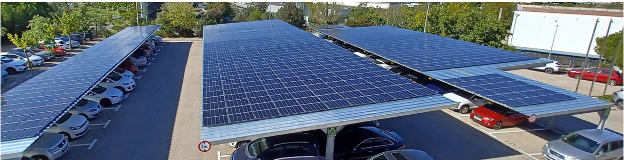
Instalación de sistema fotovoltaico con 187 kWp ubicados en la sede de Sportium y B2B situada en Sant Cugat (Barcelona)
